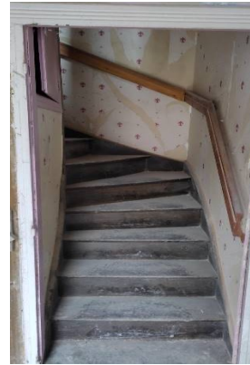
Accès à l'étage
